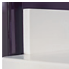
Copete en ángulo recto: se fija con sellador de silicona
